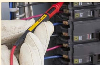
Reduzca la exposición de la punta de la sonda para realizar pruebas según CAT III
